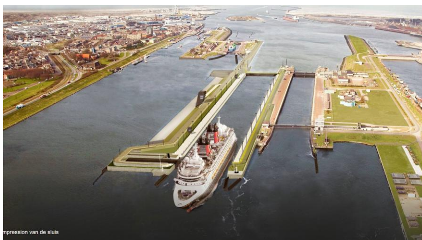
Zeesluis IJmuiden, de grootste ter wereld (bron: Rijkswaterstaat)
