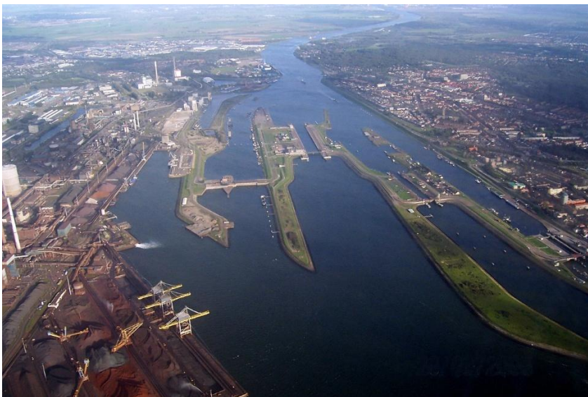
De sluizen van IJmuiden met links van het midden het gemaal en de spuisluis (bron: Debot at Dutch Wikipedia)
