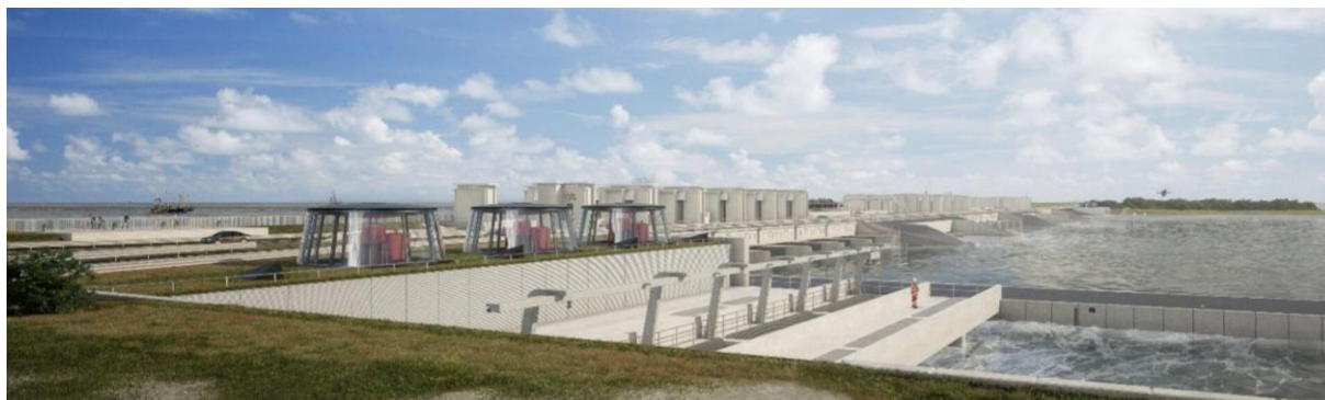
Grootste gemaal van Europa in de Afsluitdijk bij Den Oever (bron: Rijkswaterstaat)
