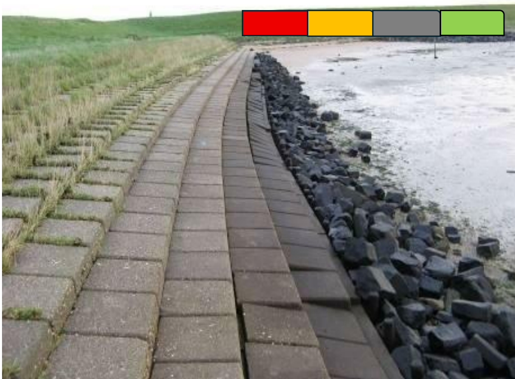
Impressie aanzicht van het binnenbeloop van een binnenmeerdijk met gekleurd kunstgras (bron foto: Mark Klein Breteler)
